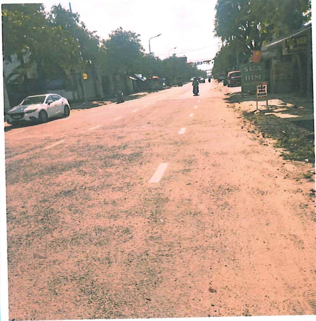
Hình 5: Tổng quan dự án đường Hùng Vương
